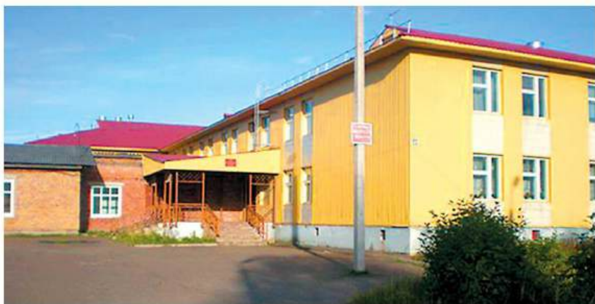
Современное здание школы.
